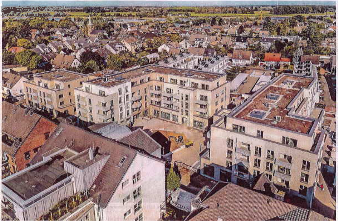
Der Gesundheitscampus an der Alten Schulstraße ist fast fertig.
